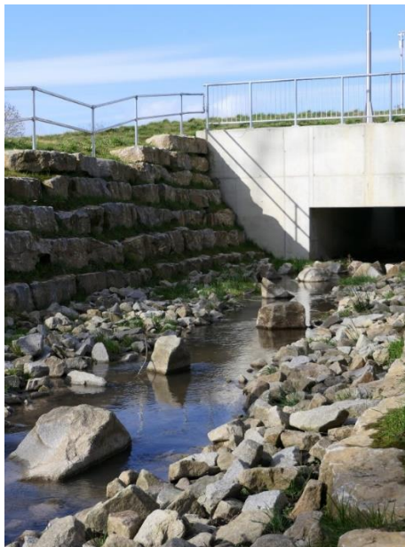
Ochsenbach - Hochwasserrückhaltebecken in Richtung Norden*
