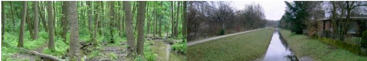
Links: naturnahes Gewässer (Strukturgüteklasse 1). Rechts: stark verändertes Gewässer (Strukturgüteklasse 5). Fotos: T. Pottgießer, www.gewaesserbewertung.de
